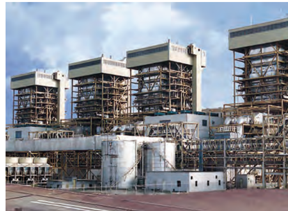
▲ بویلرهای نیروگاه شهید رجایی
