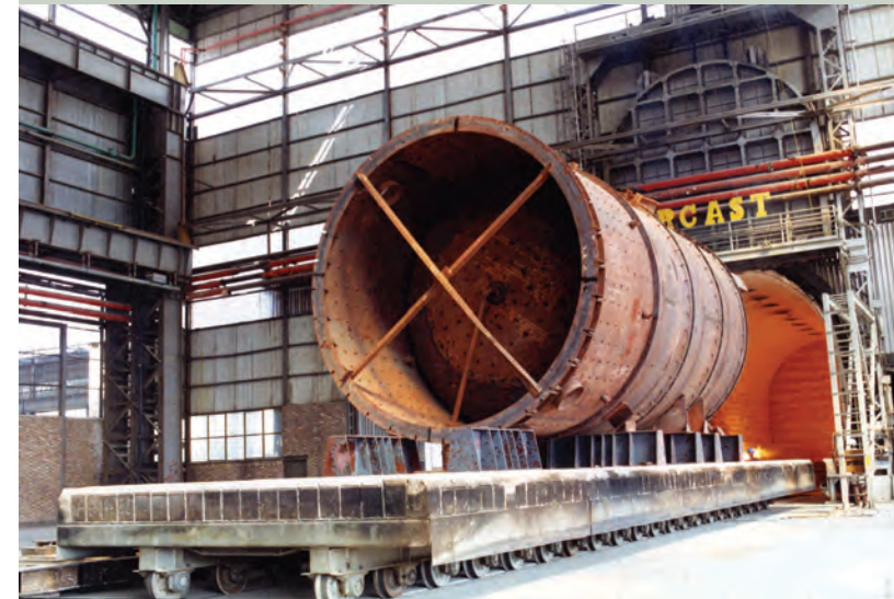
▲ کوره های عملیات حرارتی
